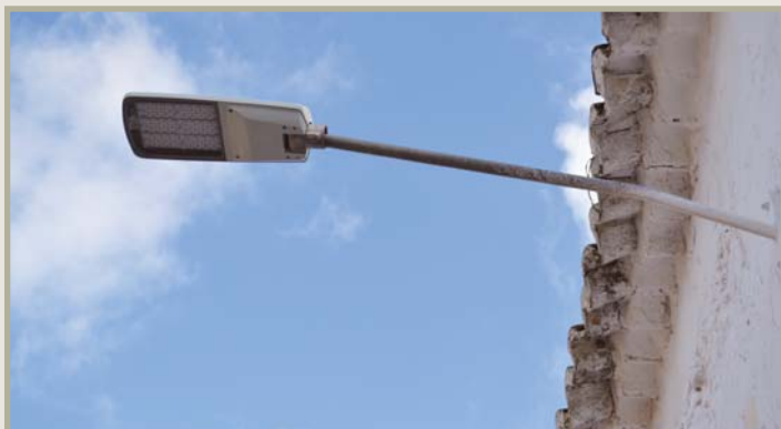
Nuevas Luminarias de Led. Se realizó una auditoría energética y se cambiaron las farolas por otras de mayor ahorro
