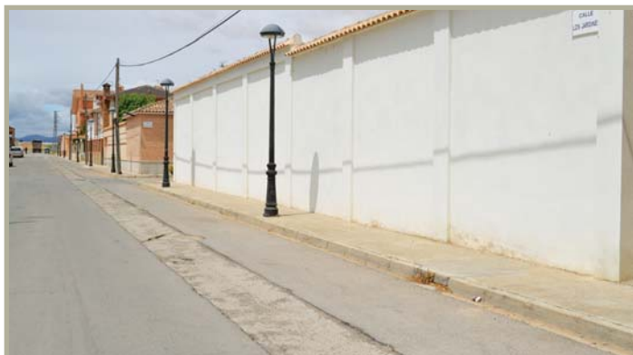
Se metió un nuevo Colector en la Calle Jardines
