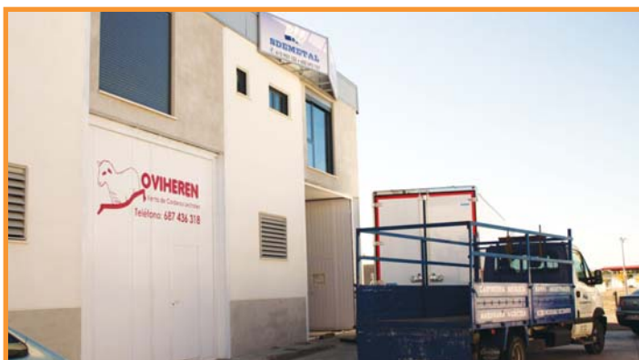
Vivero de Empresas con las mismas ya instaladas
