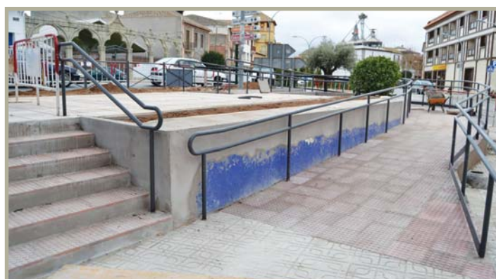
Obras de accesibilidad
