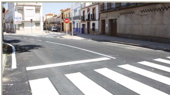
Obras en el barrio de San Antón
