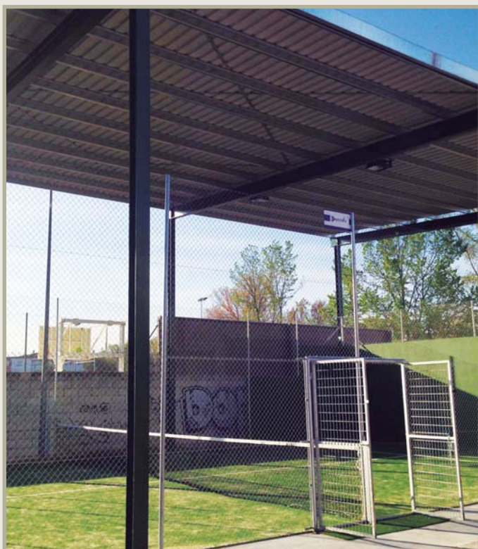
Pista de pádel cubierta en construcción
