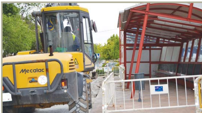
Llegada del gas natural con diversas obras para su distribución
